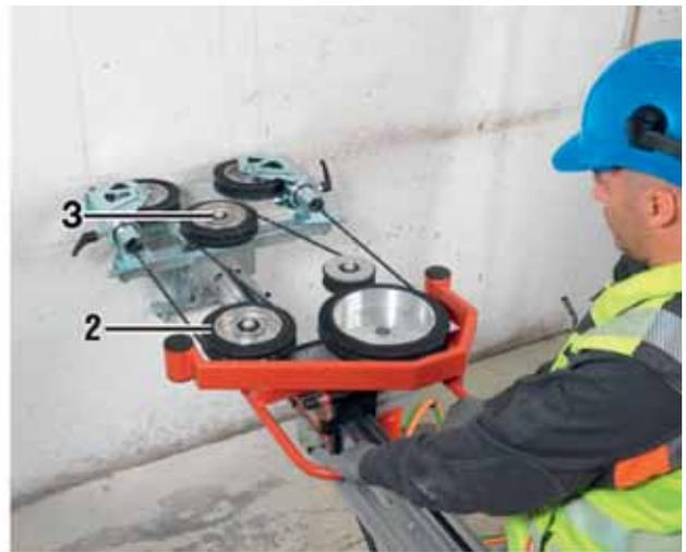
1. Faire d'abord passer le câble de scie à travers l'élément de structure à scier, arrondir les arêtes trop vives en rodant le câble de scie manuellement dans un mouvement de va-et-vient jusqu'à ce qu'il puisse être facilement tiré à la main.
