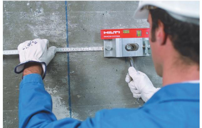
6. Poser le pied de rail, aligner et serrer légèrement les écrous à embase.
