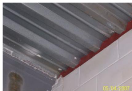
膨胀型防火密封胶封堵型式
