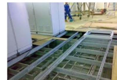
一个综合了桥架、地板、设备的整体支撑系统
