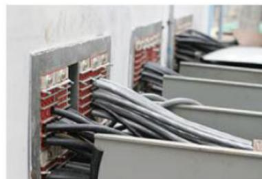
电缆进入电气机房的孔洞封堵
