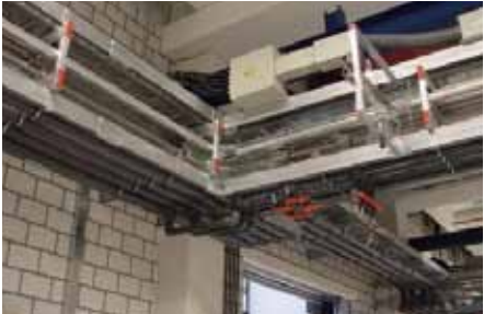
传统焊接破坏美观，影响防腐性能，力学性能无法保障 喜利得直接紧固系列无需焊接，美观高效
