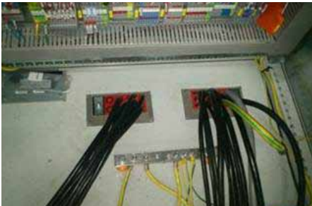
电缆进入电气机房孔洞封堵
