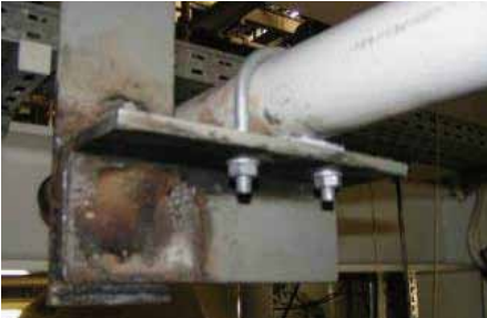
传统焊接破坏美观，影响防腐性能，力学性能无法保障 喜利得直接紧固系列无需焊接，美观高效
