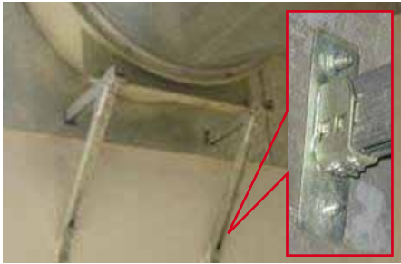
应用二：吊挂系统固定管道/仪表设备
