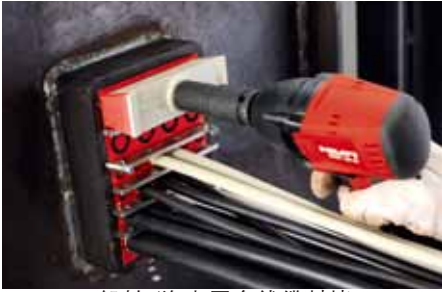
船舶/海上平台线缆封堵
