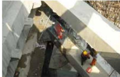
混凝土支撑切割
