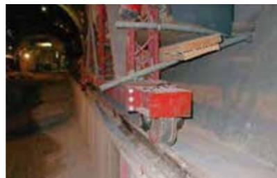
盾构机导轨固定
