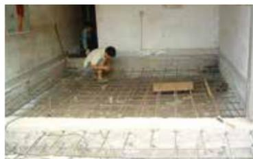
地铁线路穿越房屋基础加固
