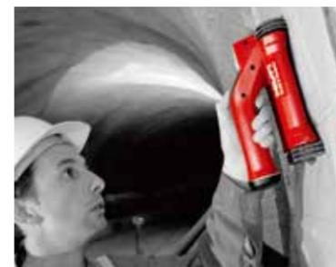
施工前须使用钢筋探测仪确认钢筋位置，避免破坏原结构
