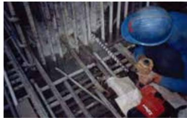
底板钢筋接驳器错漏埋补救
