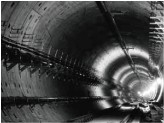
弧形槽式预埋件HAC-T 在隧道管廊的应用
